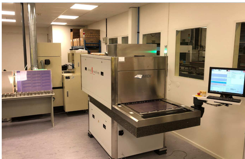
Schmoll MDI direktexponering nu installerad i vårt nya renrum i Malmö-fabriken
